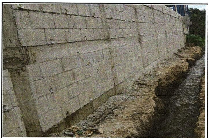
Foto 4: finalización del mantenimiento-mejoramiento del muro de contención.
