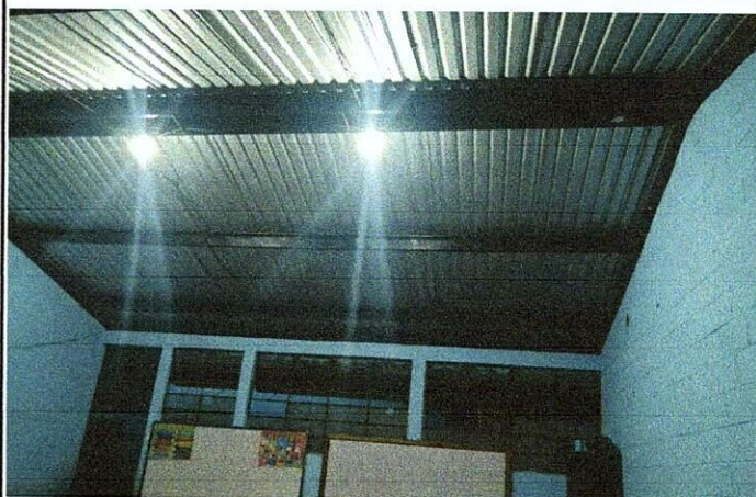
Foto 2: finalización del mejoramiento del sistema eléctrico.
